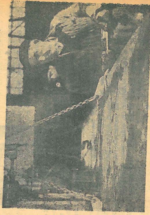
Göggök és daru segítségével emelik a hatalmas hajólemezeket az oló alá, ahol méreire vágják. Rédei Gáspár brigádja már övek óta végzi selejmentesen ezt a munkát a Balatonfüredi Hajgyárban.
