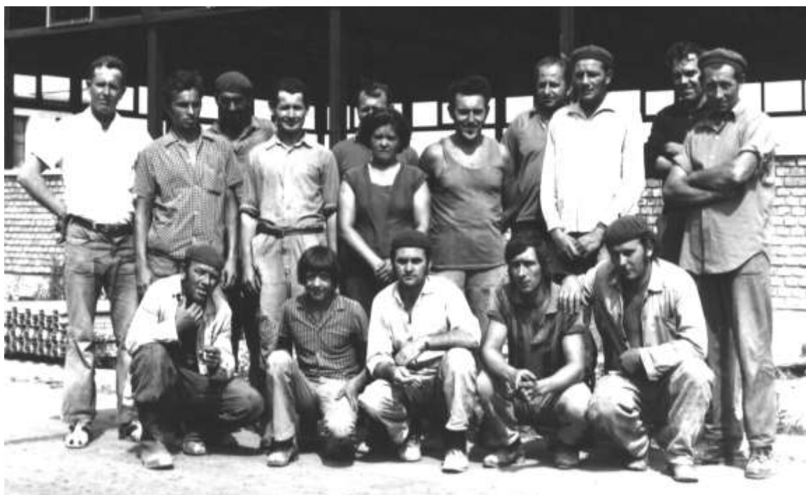
Szili György építésvezető brigádja.
